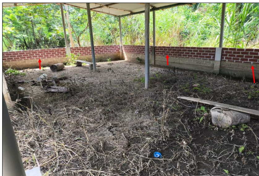
FIGURA N°05 VISTA DE LOS DAÑOS CAUSADO POR LA INUNDACION DE LA QUEBRADA SAVIA (RIO SAVIA) A VIVIENDAS COLINDANTES, CON ELLA SE PUEDE VISUALIZAR EL MATERIAL SEDIMENTARIO DEJADO EN LAS VIVIENDAS.
