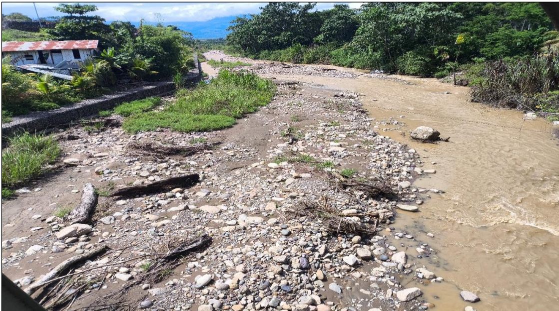
FIGURA N°04 VISTA DE PUNTO FINAL DE PUNTO CRITICO CONGLOMERADO DE MATERIAL EN EL CAUCE DE LA QUEBRADA SAVIA (RIO SAVIA) Y CON ELLA DA ORIGEN A EROSIÓN DE RIBERA MARGEN DERECHA E IZQUIERDA. DADO A QUE EL MURO DE GAVION SE ENCUENTRA COLMATADO, LO CUAL ES EXPUESTA LA PROTECCION DE LA POBLACION, ES NECESARIO LA DESCOLMATACION DE LA QUEBRADA SAVIA PARA SU DEBIDA FUNCION DE PROTECCION
